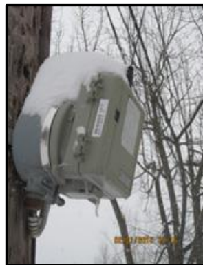
En DTE dataindsamlings enhed eller relæstation monteret på en telefonpæl
